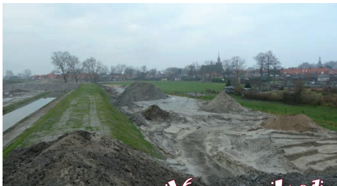
Aanleg nieuwe vesting IJzendijke
