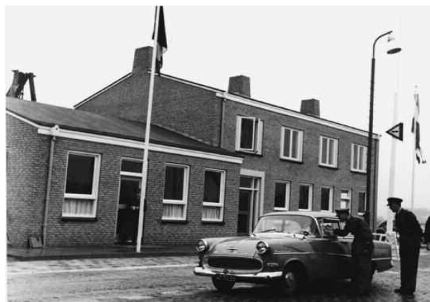
Douanekantoor 'Veldzicht' in 1960. Rechts het Nederlandse deel en links het Belgisch gedeelte
